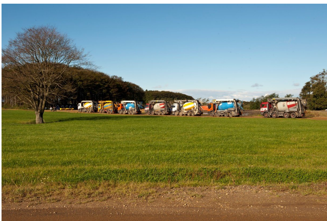
Foto 4.2 Betonbiler holder klar til at støbe fundamentet.
