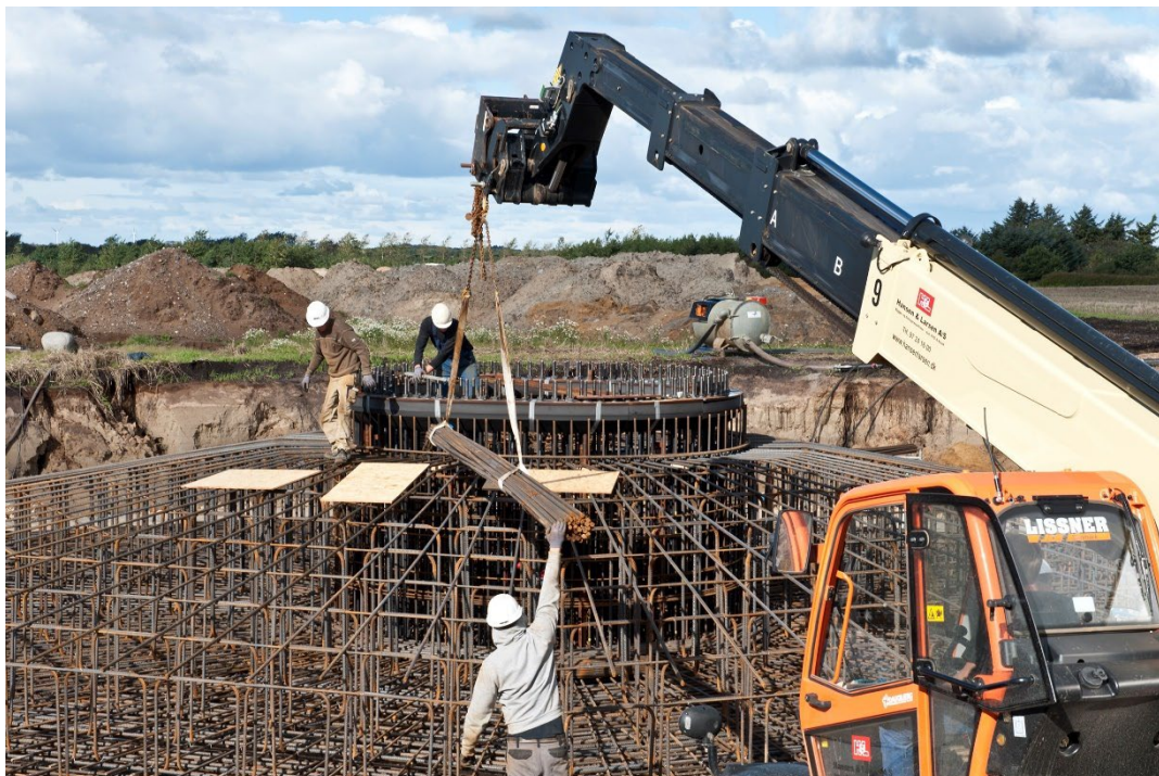
Foto 4.1 Armeringen i fundament etableres.
