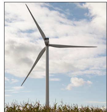
Typisk dansk vindmølle-design med lukket rørtårn, møllehus og tre vinger.
